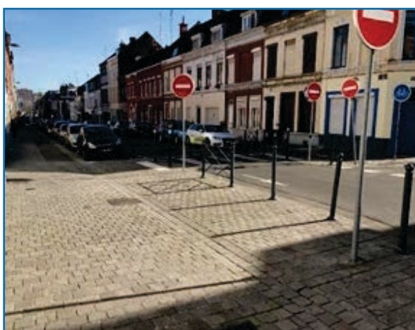
Roubaix : rue de Lille (traitement ancien)
