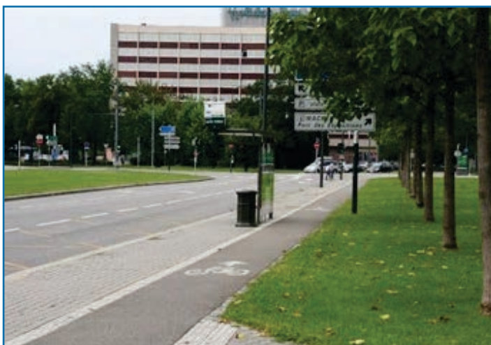
Boulevard extérieur à Strasbourg
