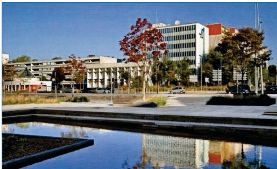
▶ Mons-en-Barœul : des espaces publics dont les usages sont clairement définis
