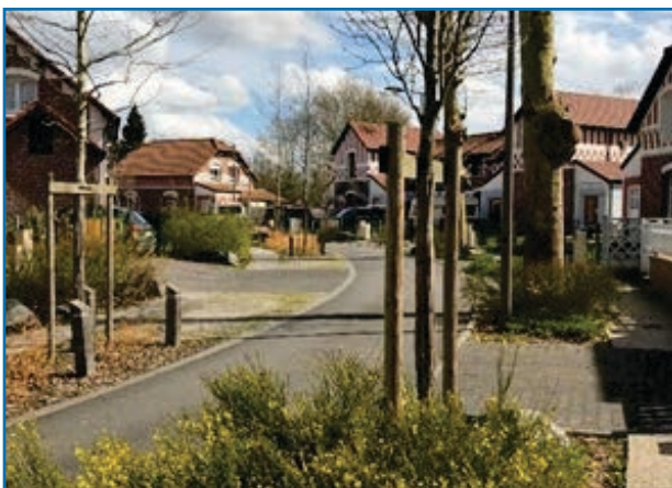
Dourges : cité Bruno (avec noues pour recevoir les eaux pluviales)
